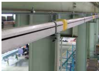
走行給電施工例
