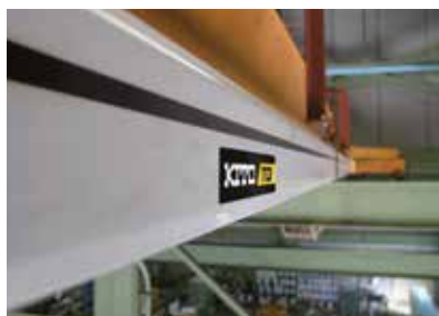
横行給電施工例
